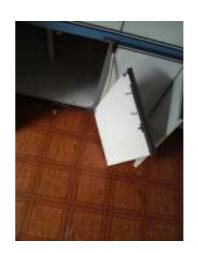
キッチン ○汚れた床→クッションフロア(フローリング柄へ)張り替え ○流し台・ガス台(錆び・ドア壊れ)→新規交換 ○枠廻り→明るく塗装
