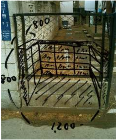
ゴミ置き場 ○ブロックにて囲み、ダストボックス設置
