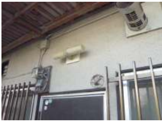
外部 照明器具 支え不良→支え板取付補修
