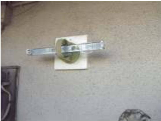
外部 照明器具 支え不良→支え板取付補修
