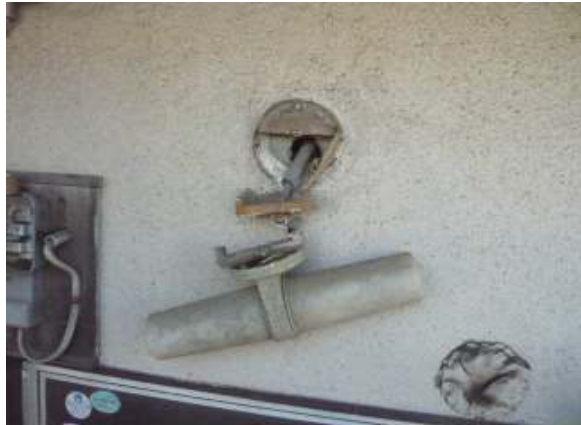
外部 照明器具 支え不良→支え板取付補修
