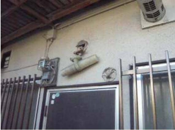
外部 照明器具 支え不良→支え板取付補修
