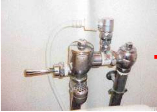
トイレバルブ水漏れ→交換
